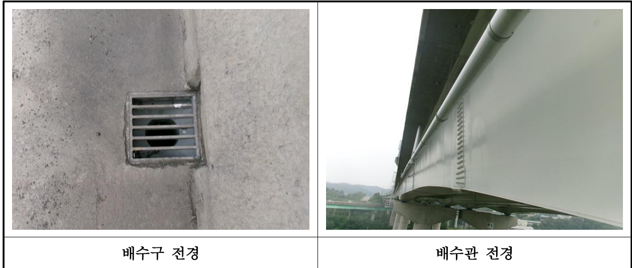
【사진 40.3.46】 배수시설 전경
