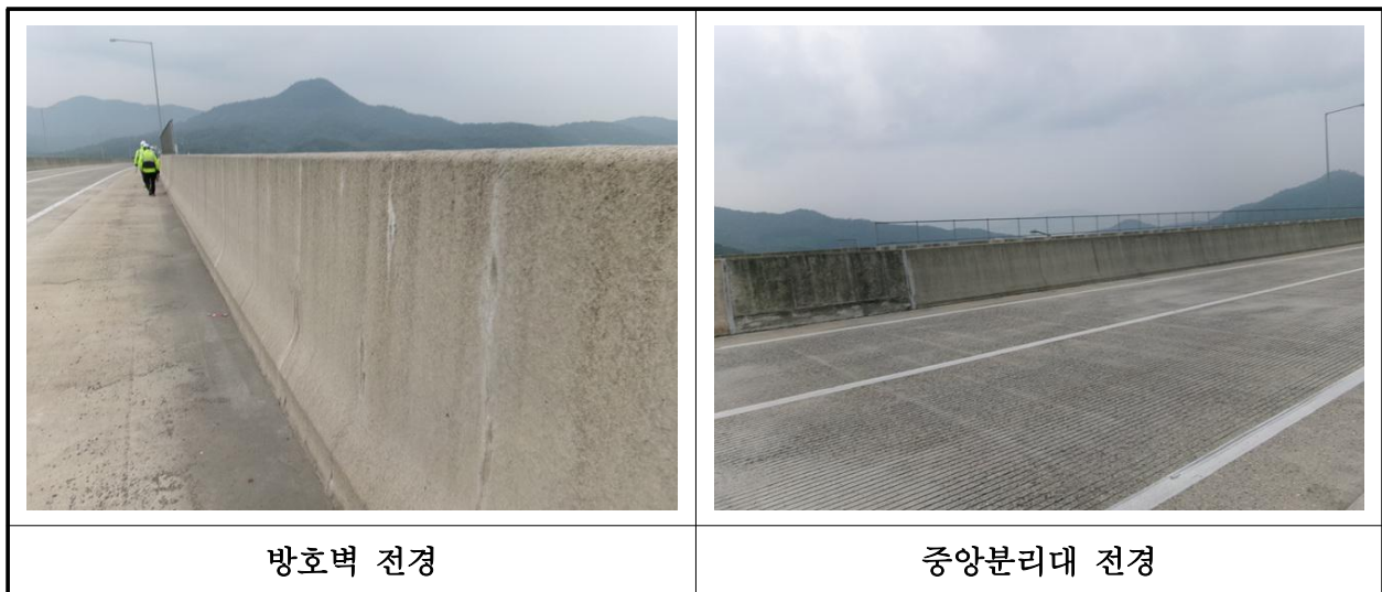
【사진 40.3.48】 방호벽 및 중앙분리대 전경
