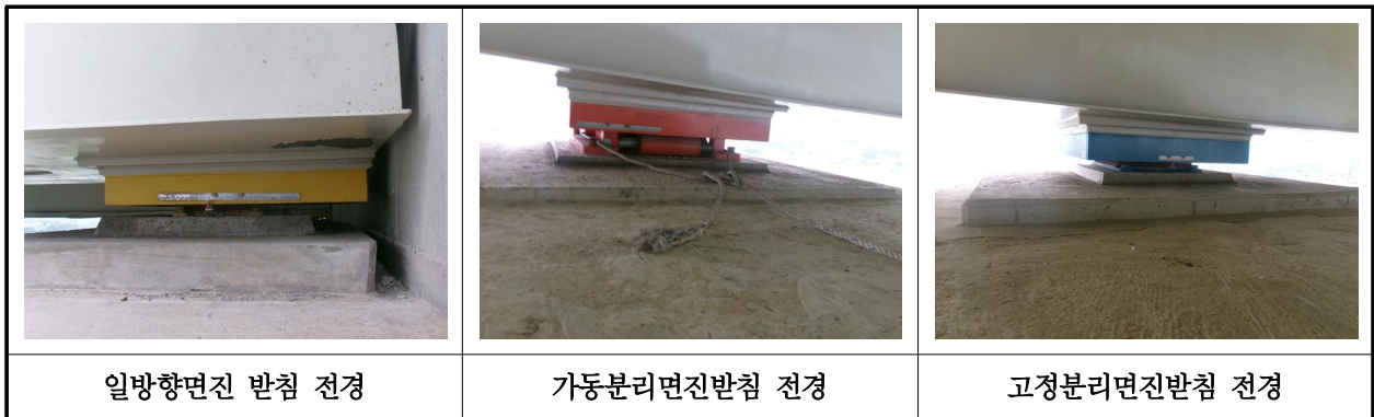
【사진 40.3.12】 교량받침 전경
