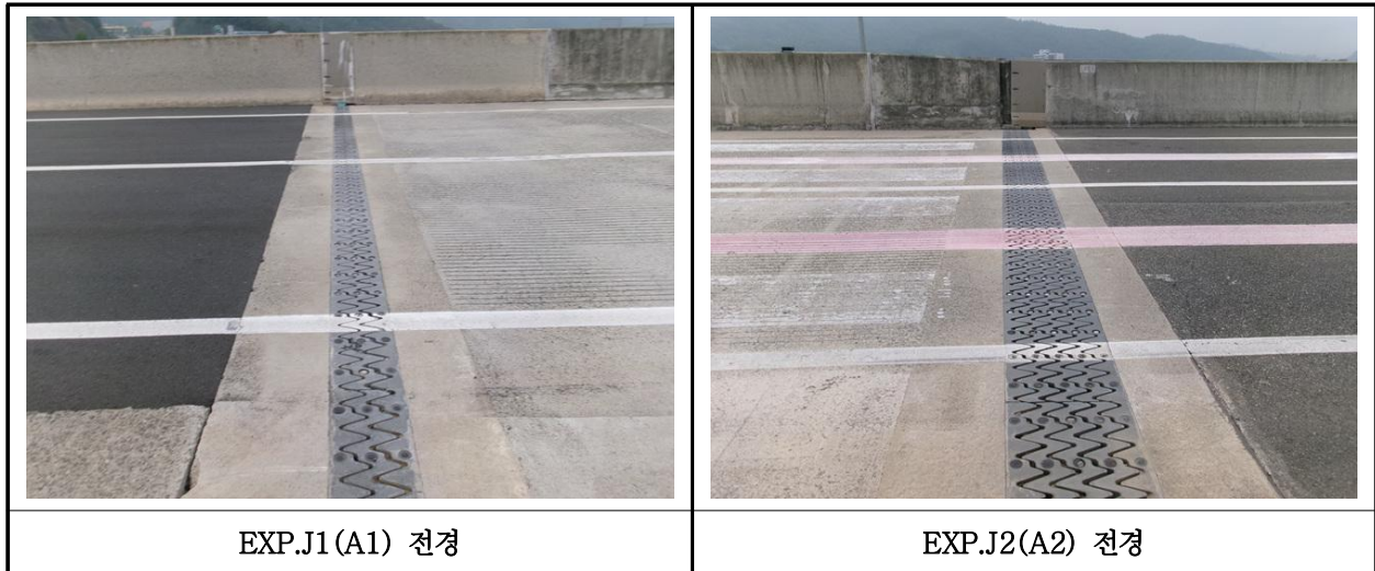
【사진 40.3.41】 신축이음장치 전경
