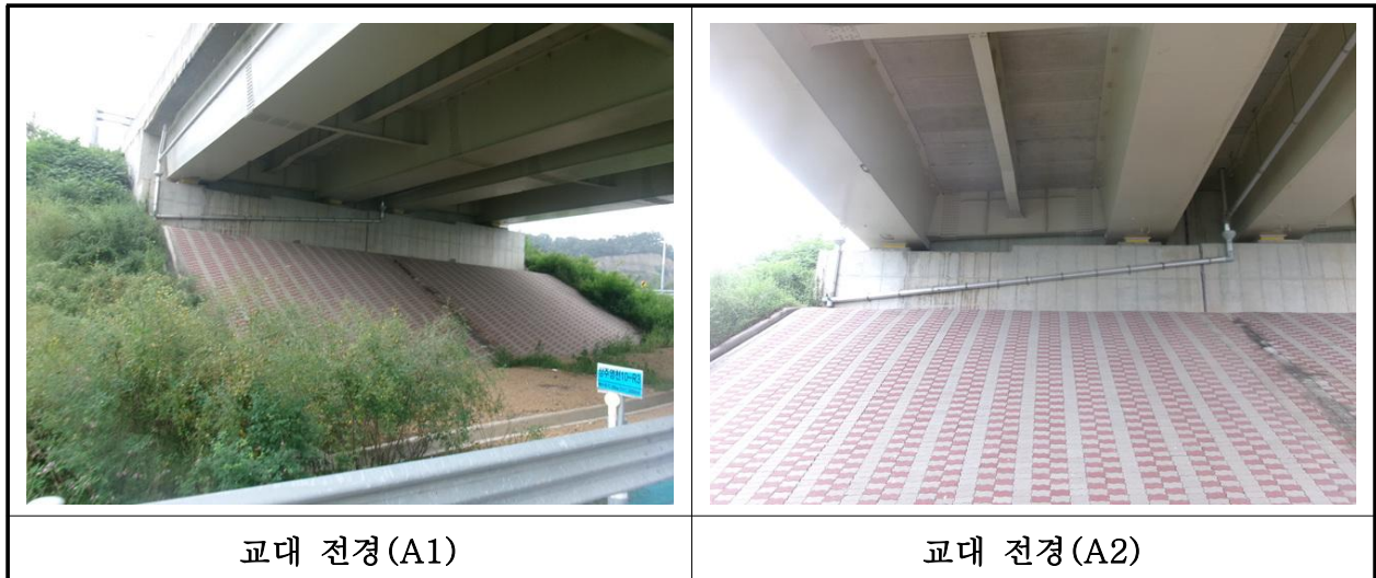
【사진 40.3.33】 교대 전경
