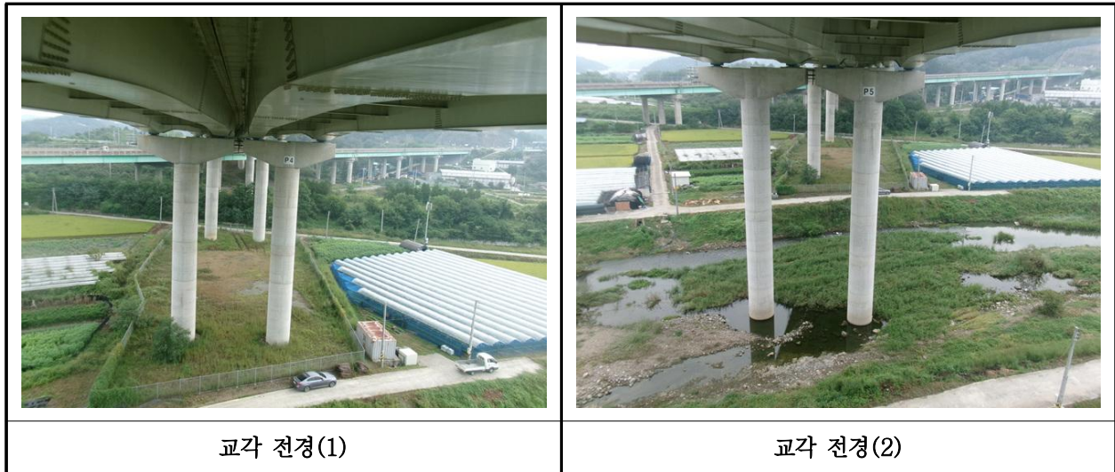
【사진 40.3.10】 교각 전경
