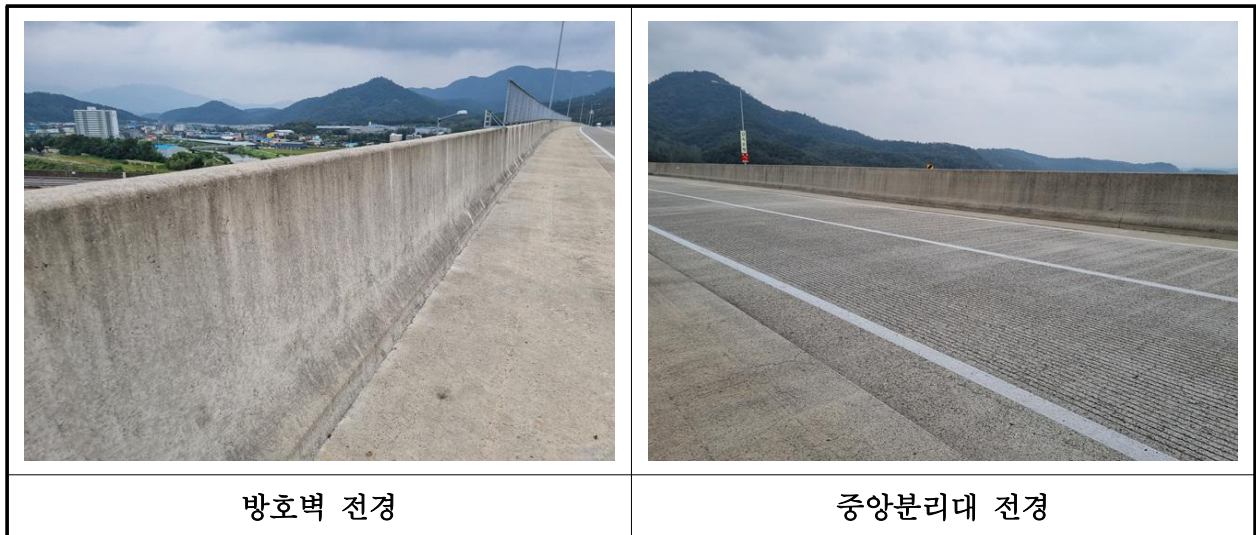
【사진 40.3.23】 방호벽 및 중앙분리대 전경
