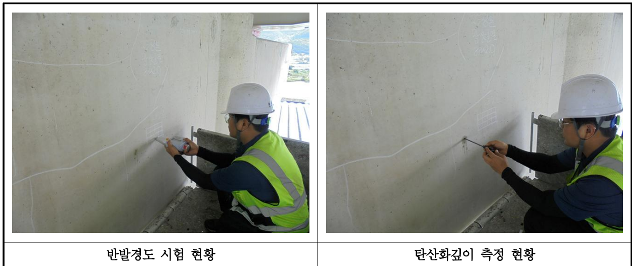
【사진 40.4.1】 콘크리트 내구성조사 현황
