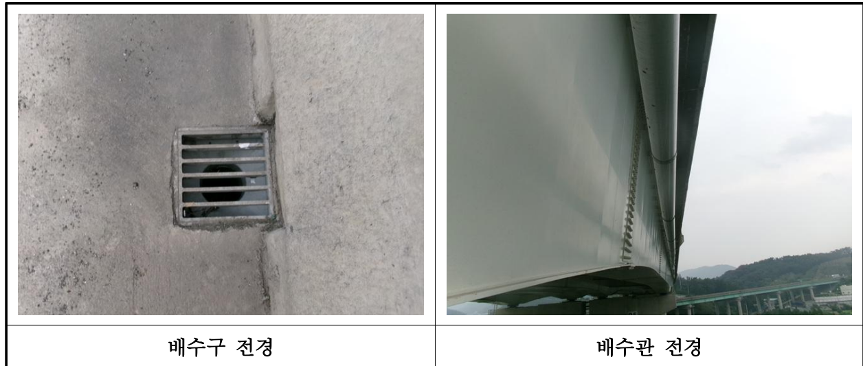
【사진 40.3.21】 배수시설 전경
