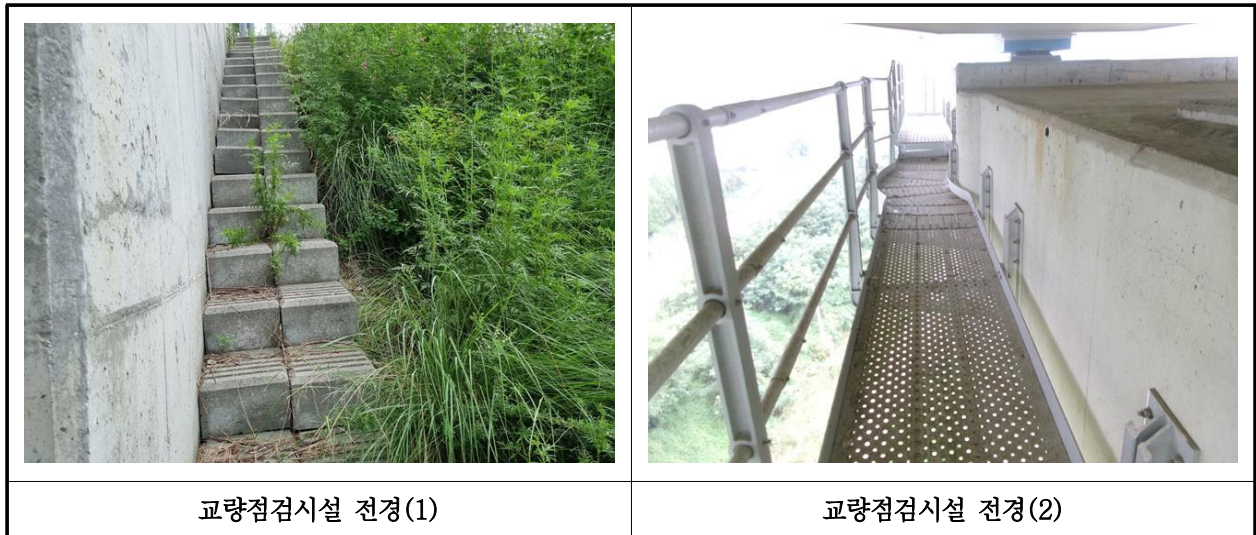
【사진 40.3.25】 교량 점검시설 전경
