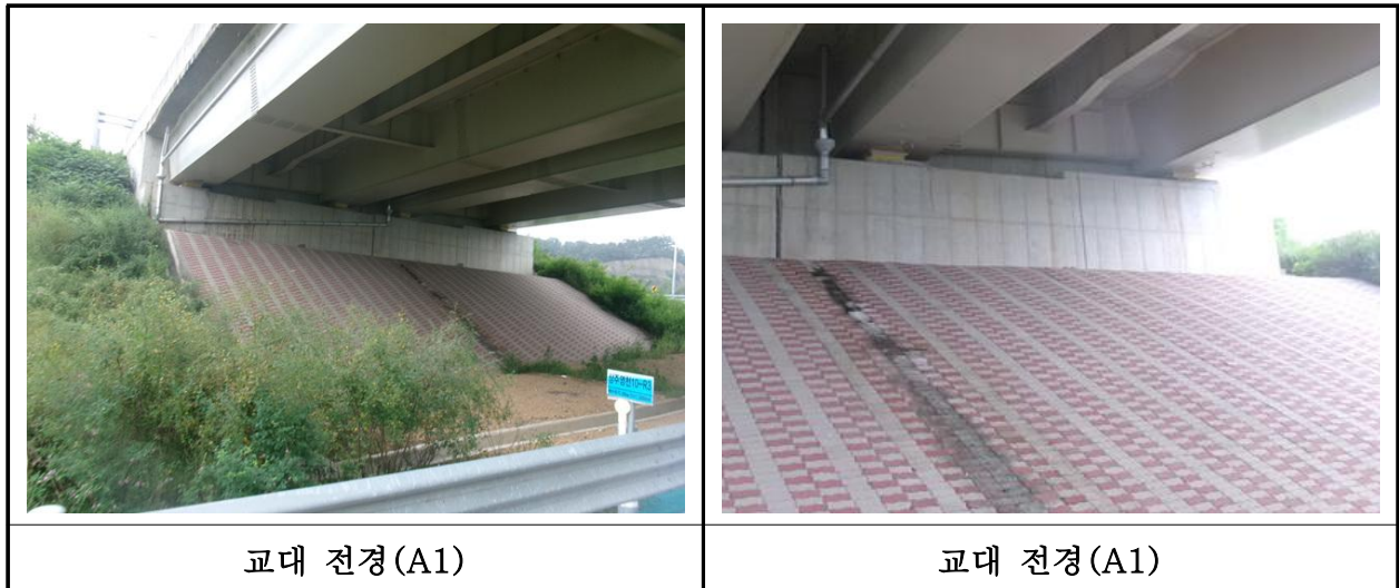
【사진 40.3.8】 교대 전경
