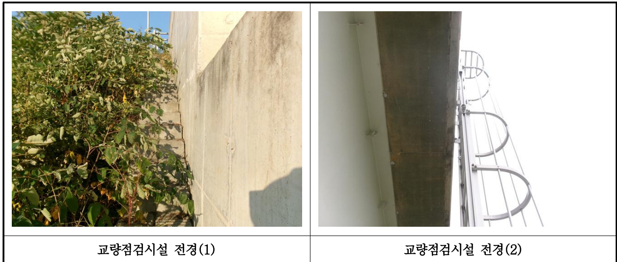
【사진 40.3.50】 교량 점검시설 전경
