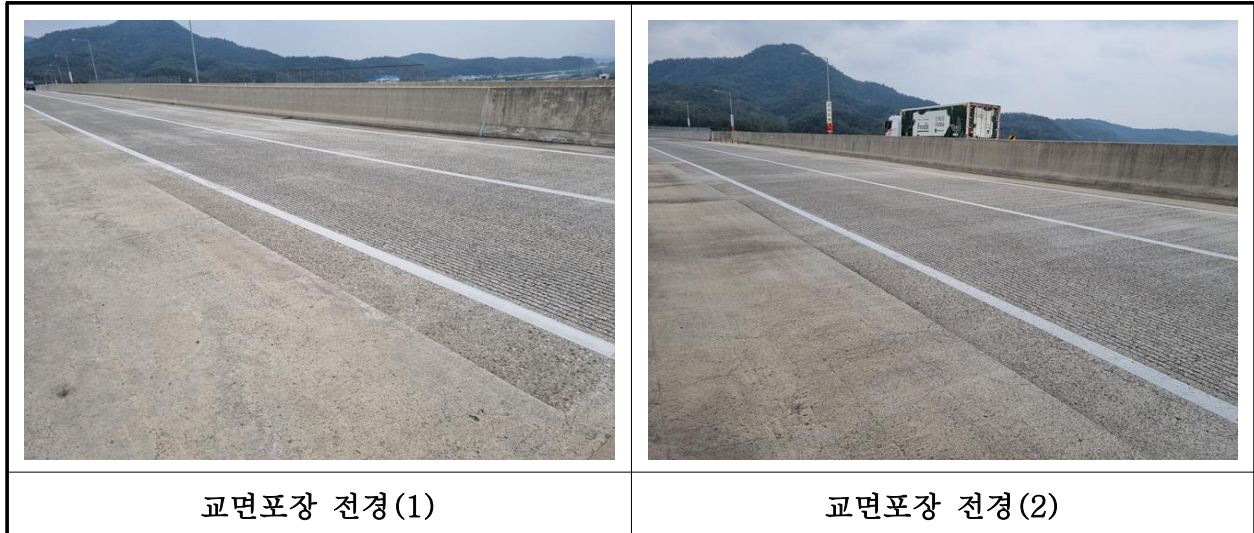
【사진 40.3.19】 교면포장 전경
