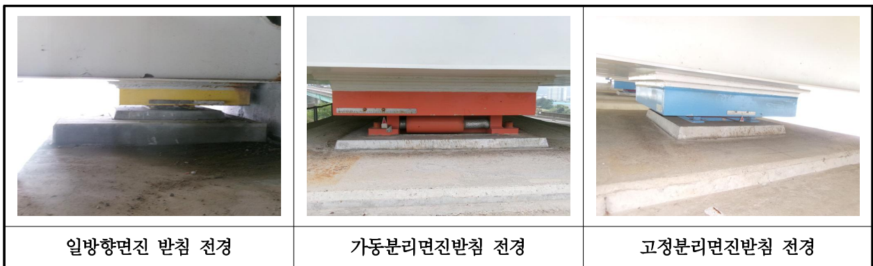
【사진 40.3.37】 교량받침 전경
