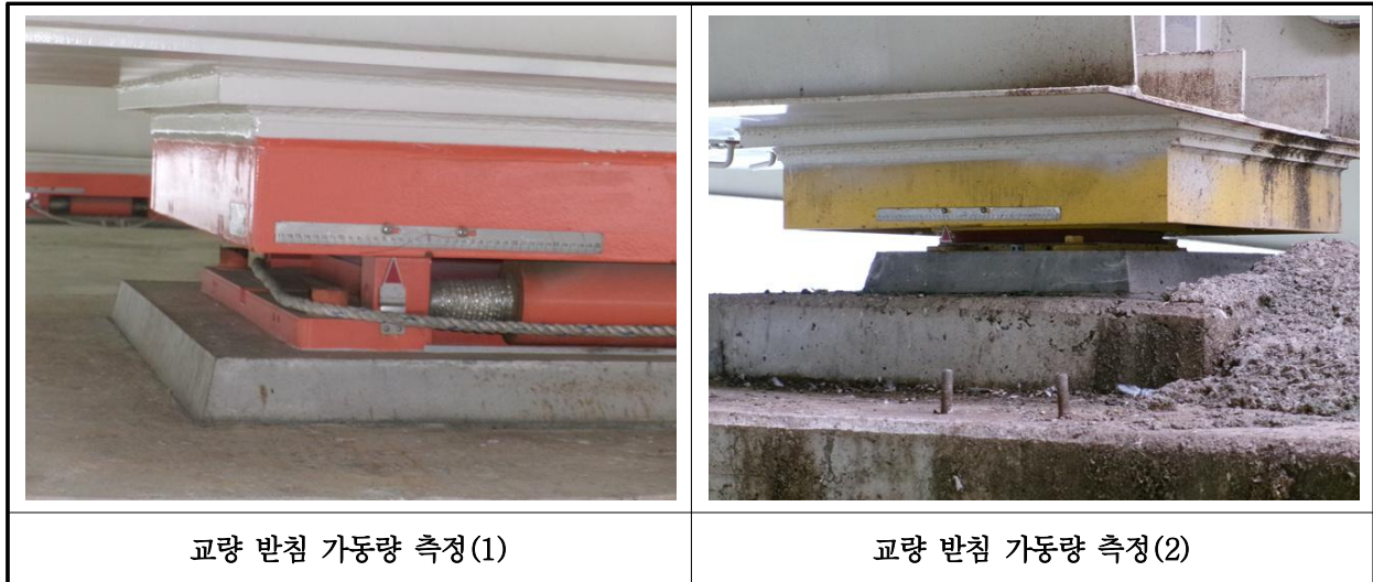
【사진 40.3.15】 교량받침 이동량 상태
