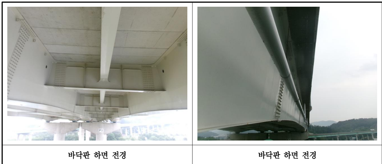
【사진 40.3.2】 바닥판하면 전경
